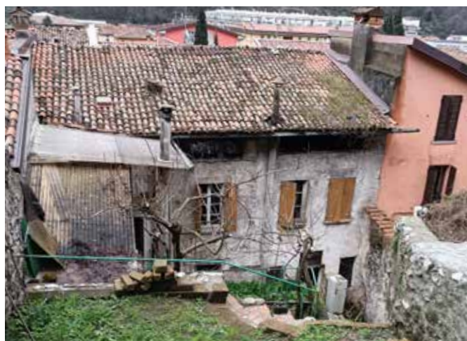
Fig. 46 - Esterno con vista della copertura.
