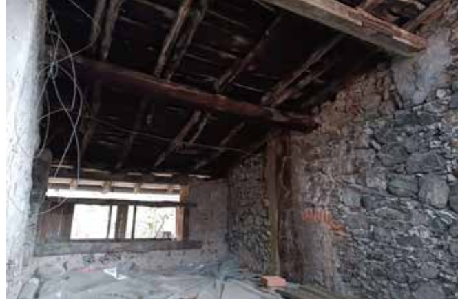
Fig. 45 - Interno con vista del sottotetto.
