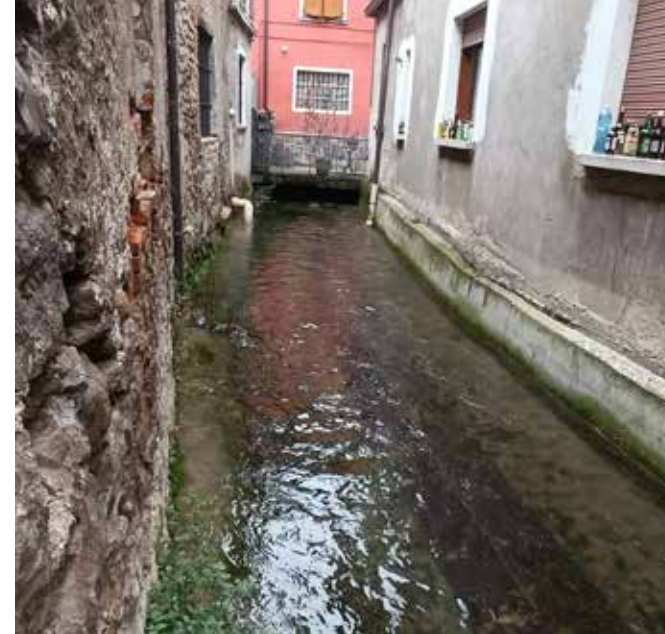
Fig. 56 - Porzione a vista del canale Acqualunga.
