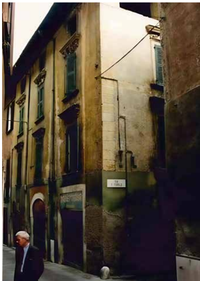
Fig. 23 - Angolo via San Carlo: l'edificio evidenzia un intonaco con bugnato.
