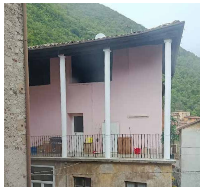
Fig. 20 - Vista delle colonne in muratura rivestite da intonaco e terminanti con capitello.
