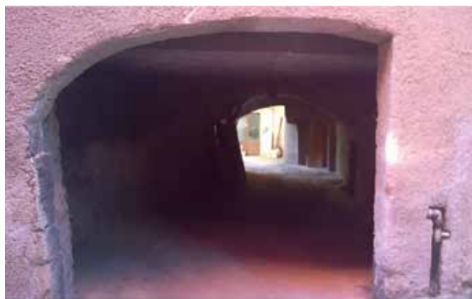
fig. 55 - È probabile che il volto fosse completo. In seguito a delle trasformazioni è stato in parte tamponato.
