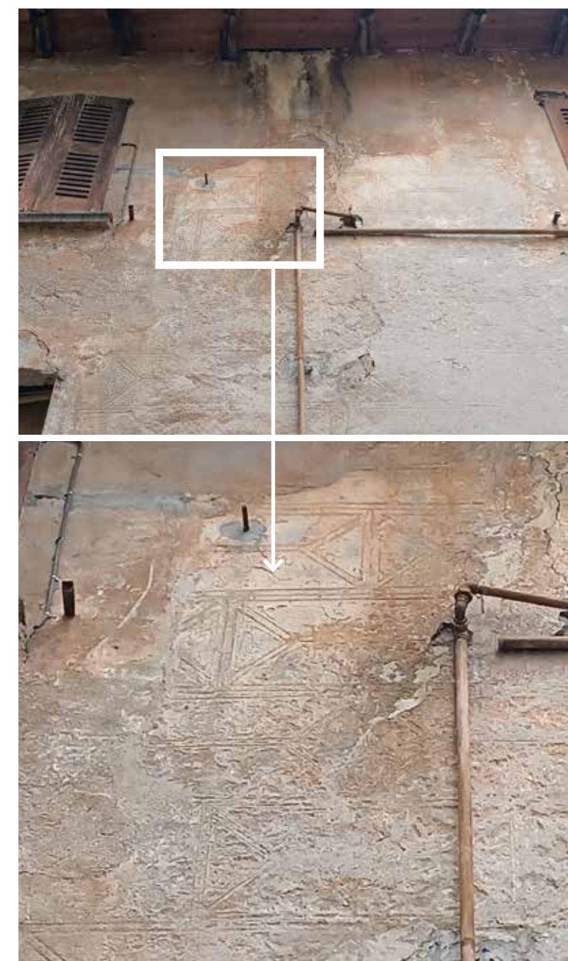
fig. 13 - Intonaco a graffito e dettaglio
