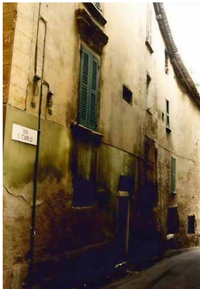
Fig. 22 - Prospetto lungo via San Carlo.
