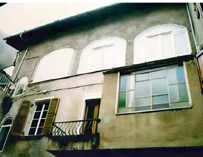
Fig. 35 - Loggiato interno al piano secondo.
