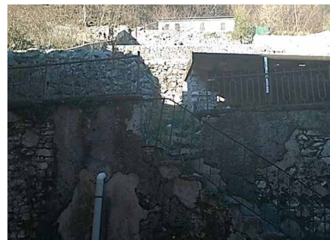
Fig. 49 - Scala interne che conducono al terrazzamento a monte.
