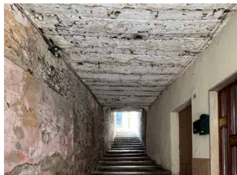
Fig. 12 - Tecnica costruttiva che si trova anche in altre case e edifici della Valle.
