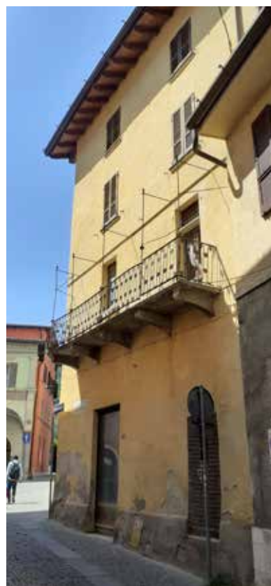
Fig. 3 - Particolare della facciata verso via Zanardelli. L'inserimento del balcone è successivo alla impostazione delle torre e in assonanza con altri casi di finitura di mensole analoghi a questo si può datare al secolo XVIII con una revisione in periodo novecentesco.
