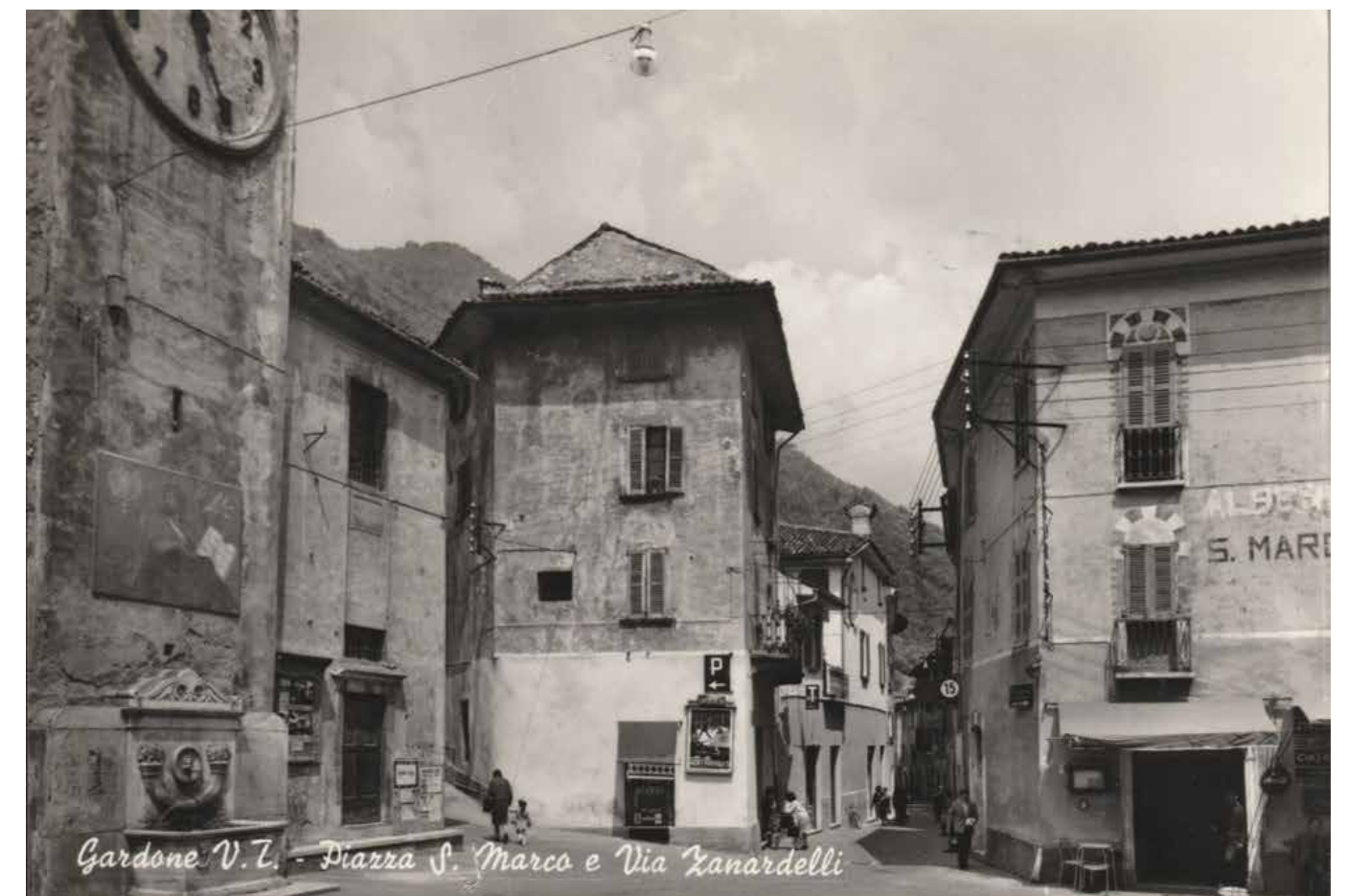
Fig. 1 - Cartolina storica di Piazza San Marco. Sulla sinistra la casa a torre con evidenziato il tetto basso ora demolito.
