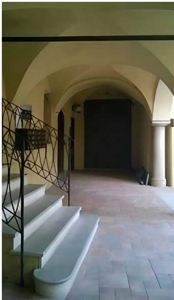
Fig. 39 - Porticato con volte a crociera su cui si affaccia la scala monumentale.
