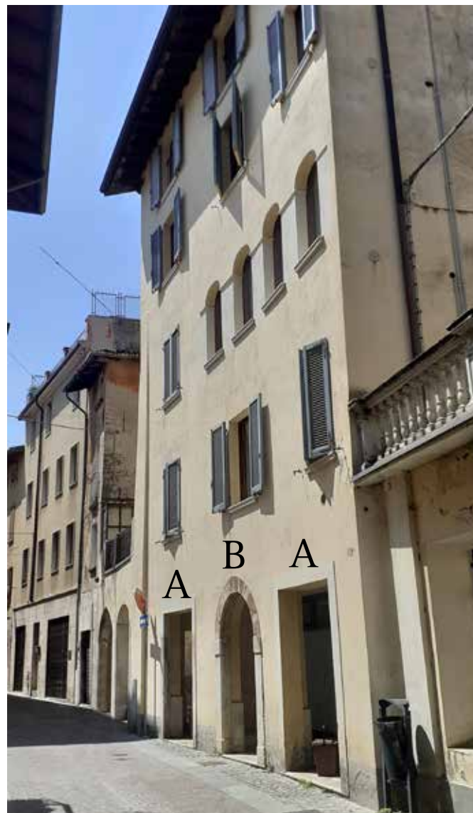
Fig. 40 - Porticato di collegamento dei due cortili del fabbricato.
