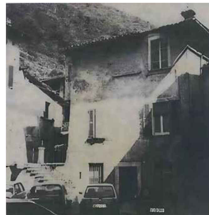
Fig. 51 - Casa Moretti al volto prima dell'intervento di restauro.
