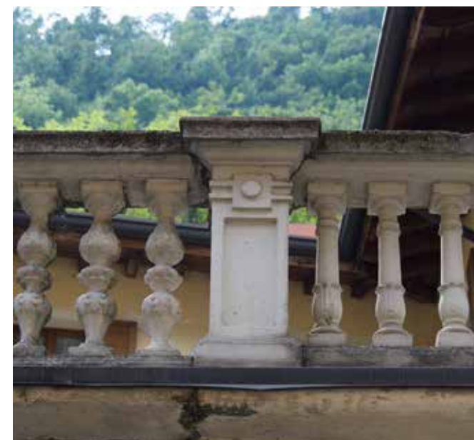
fig. 42 - Dettaglio delle due tipologie di balaustre.
