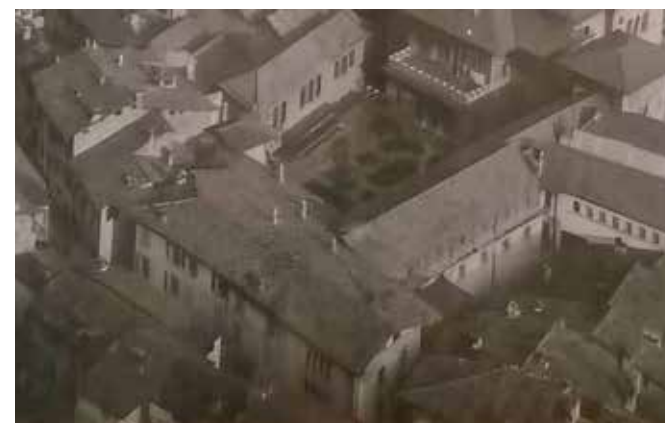
Fig. 61 - Vista aerea del complesso edilizio nel 1954.
