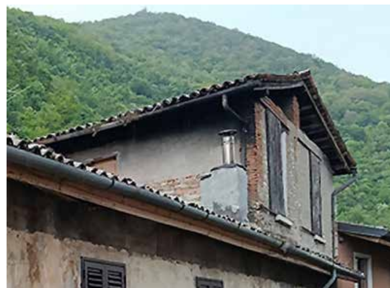
Fig. 11 - Si tratta di un sopralzo realizzato in mattoni in più riprese essendo presenti sia mattoni pieni che forati.
