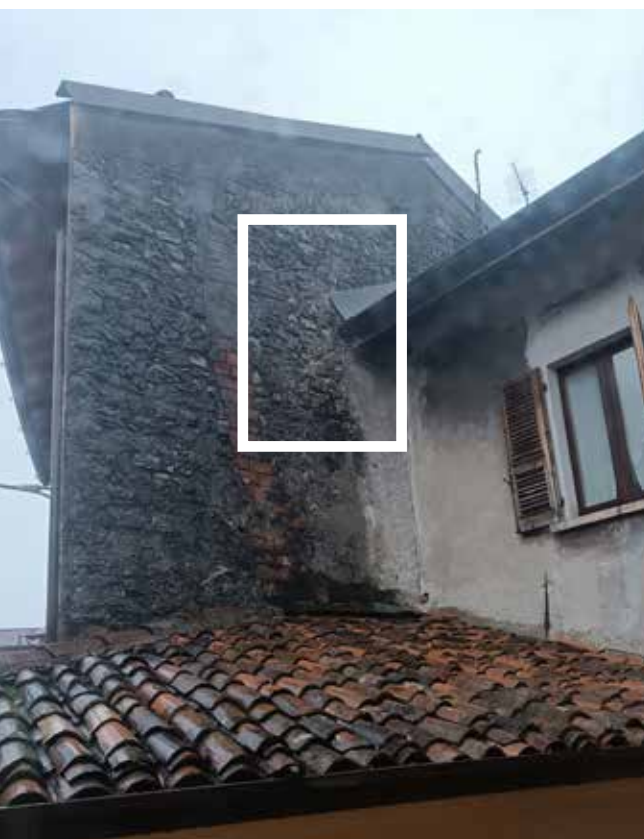
Fig. 2 - Nel riquadro si vede una monofora tamponata. Questo segno indica come l'edificio svettasse sugli altri tanto da avere finestre rivolte a nord libere.
