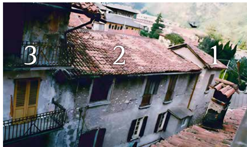
Fig. 30 - L'immagine permette l'individuazione dei diversi corpi di fabbrica aggregati.
