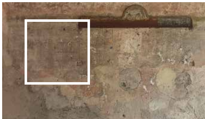
fig. 54 - Dettaglio delle incisioni sull'intonaco.
