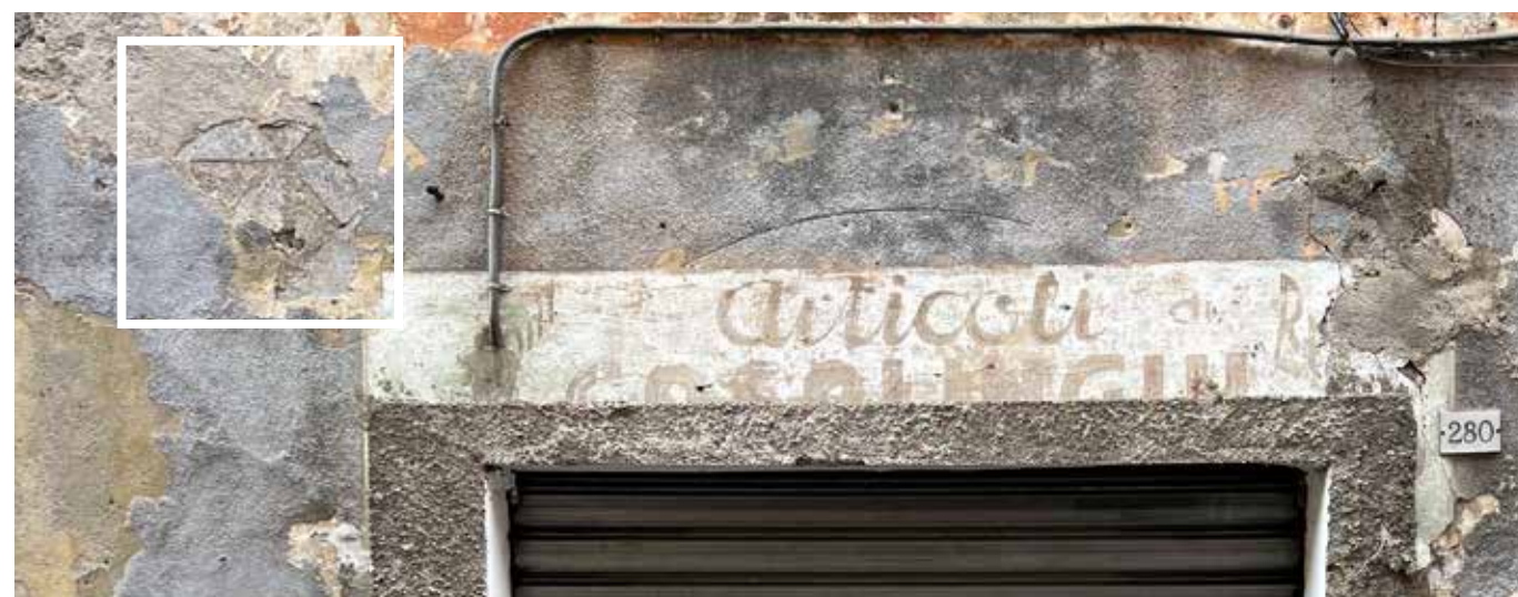
Fig. 76 - Dettaglio dell'intonaco a graffito.
