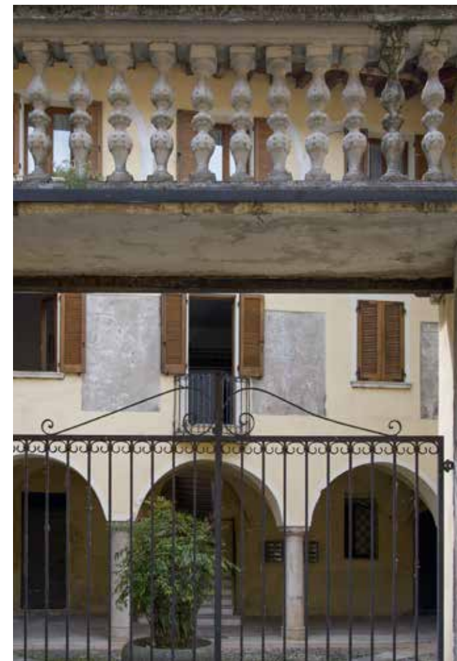
fig. 43 - Dettaglio della balastra sopra l'ingresso del cortile.
