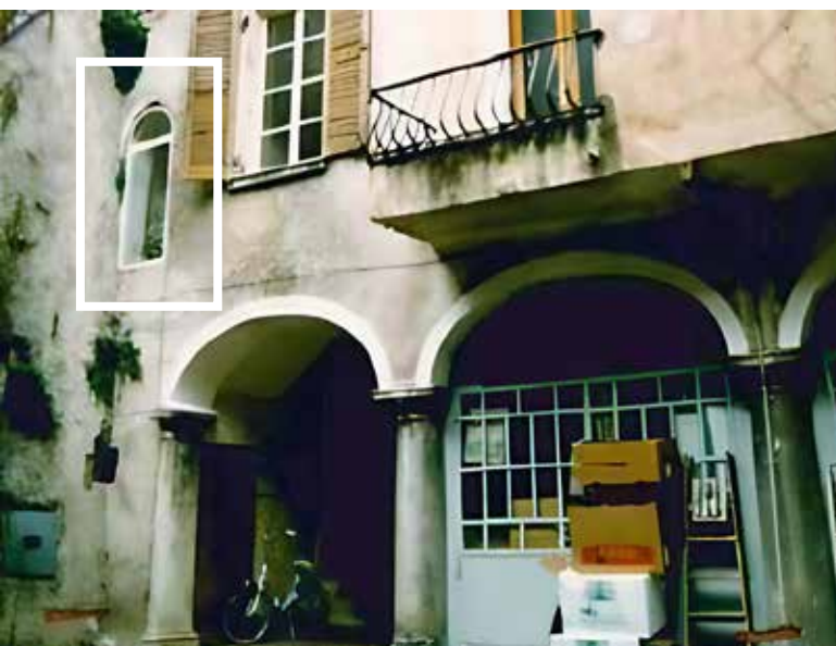
Fig. 34 - Corte interna porticato.
