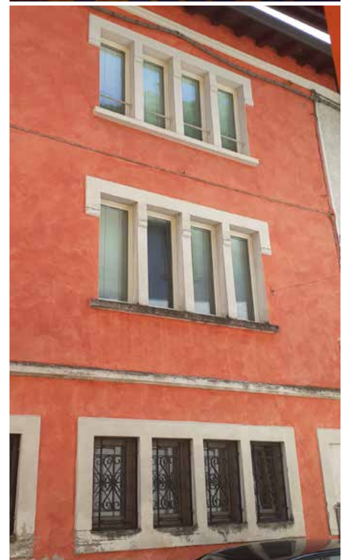
Fig. 57, 58 - Immagine prima e dopo dell'intervento di ristrutturazione.
