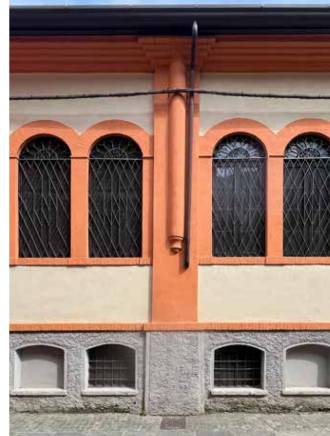
Fig. 68 - Pluviale incassato nel muro.
