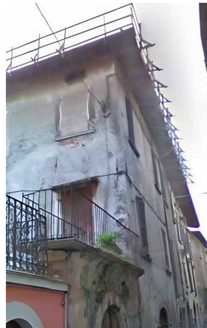
fig. 26 - Protezioni contro la caduta di elementi della copertura di Casa Grazioli.
