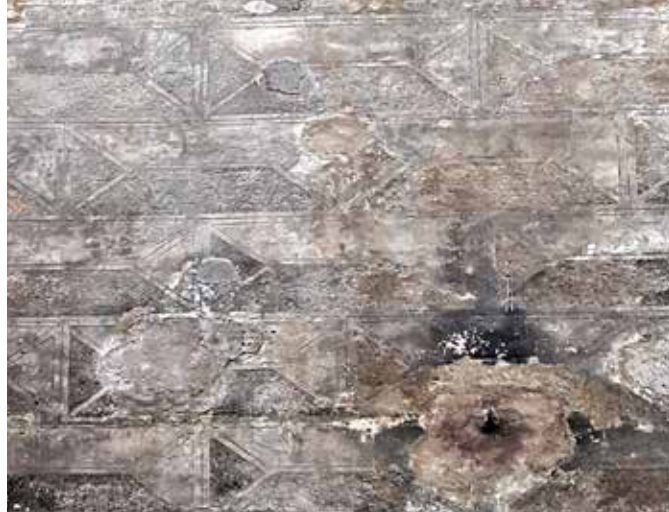
fig. 44 - Dettaglio dell'intonaco a graffito rappresentante un finto bugnato a diamante.
