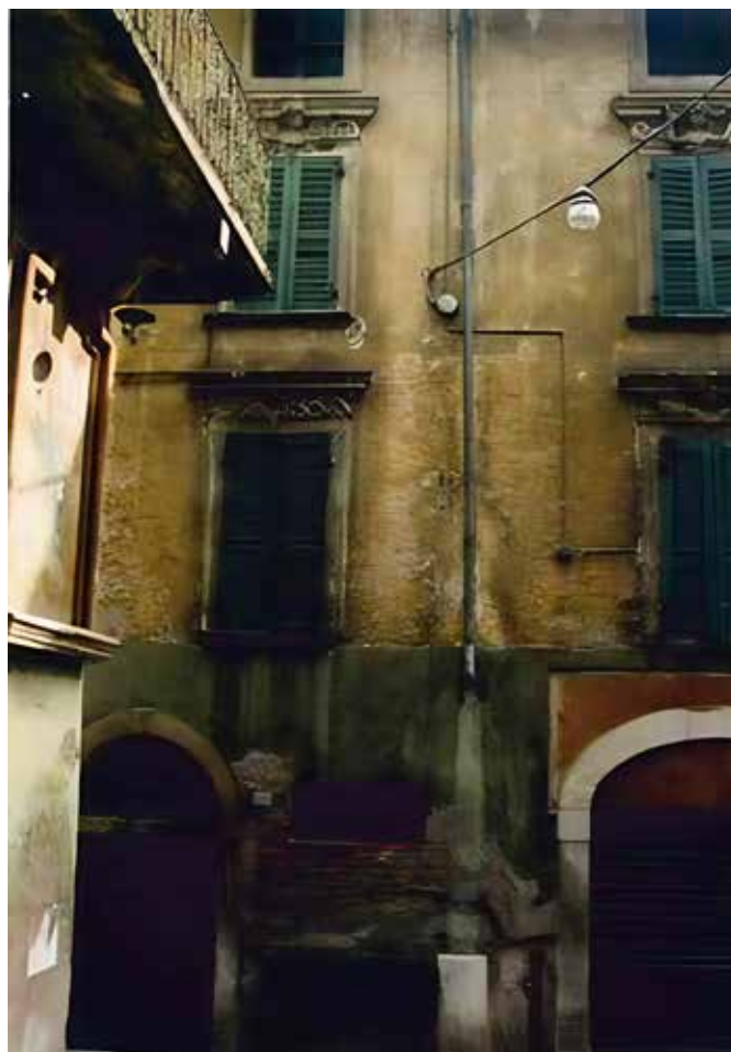
Fig. 21 - situazione prima della ristrutturazione: facciata.
