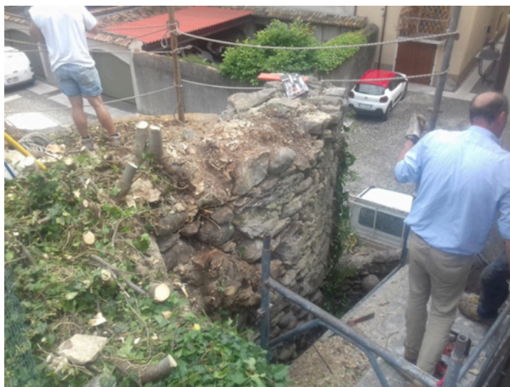
Fig. 4. San Felice del Benaco: Castello di Portese. L'immagine mostra la fase di taglio della vegetazione arbustiva insinuata nelle mura perimetrali della torre circolare.
