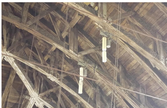
Fig. 2. Brescia: Palazzo della Loggia. Particolare degli strumenti di monitoraggio dello spostamento sulla parte superiore della struttura, con evidenziati i bulloni che sono stati oggetto negli anni di tesatura.
