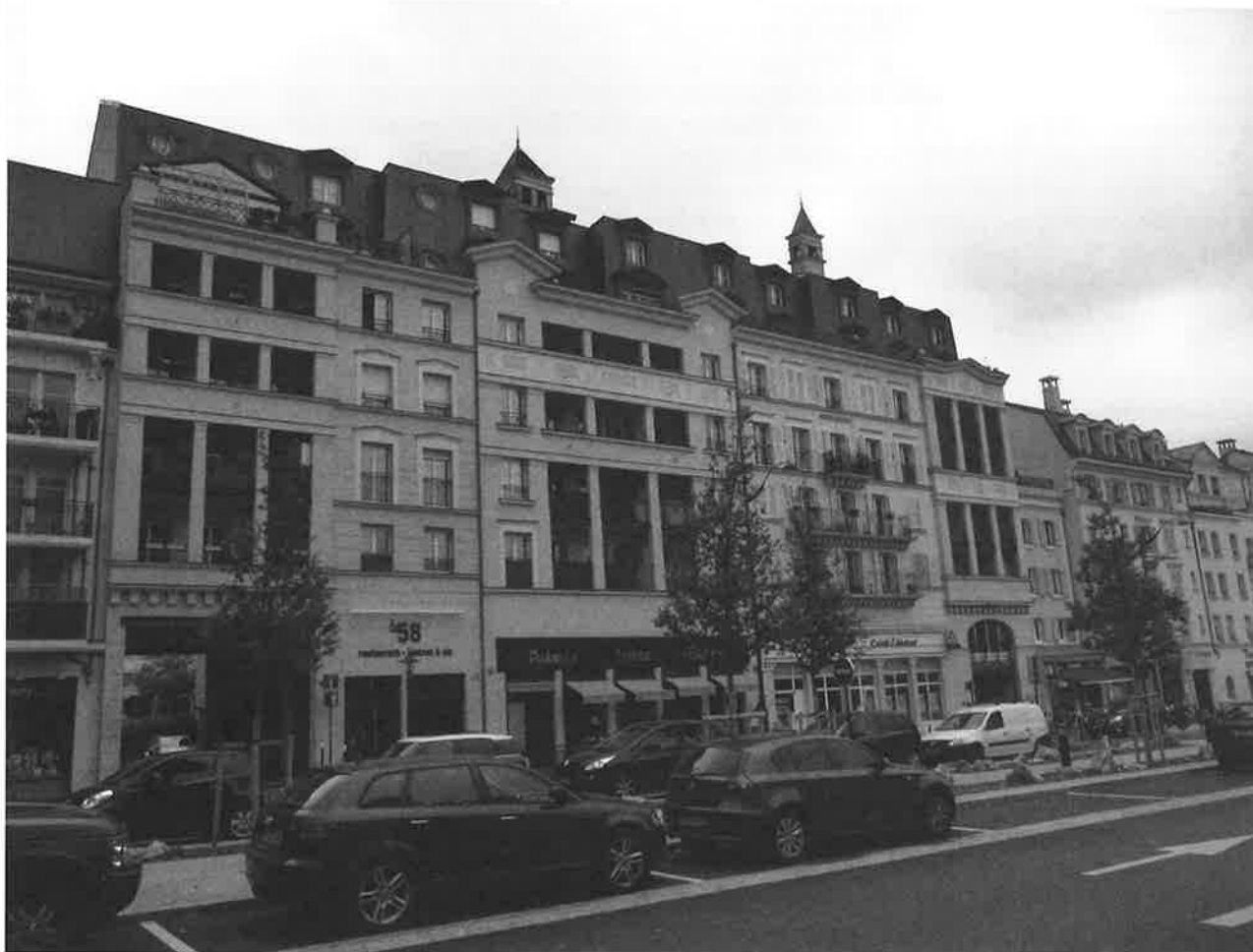
Figure 10. Le Plessis-Robinson, Cité-Jardins 3-4, Palais Colbert, avenue Charles de Gaulle (Atelier Breitman & Breitman), façade composée de cinq séquences
