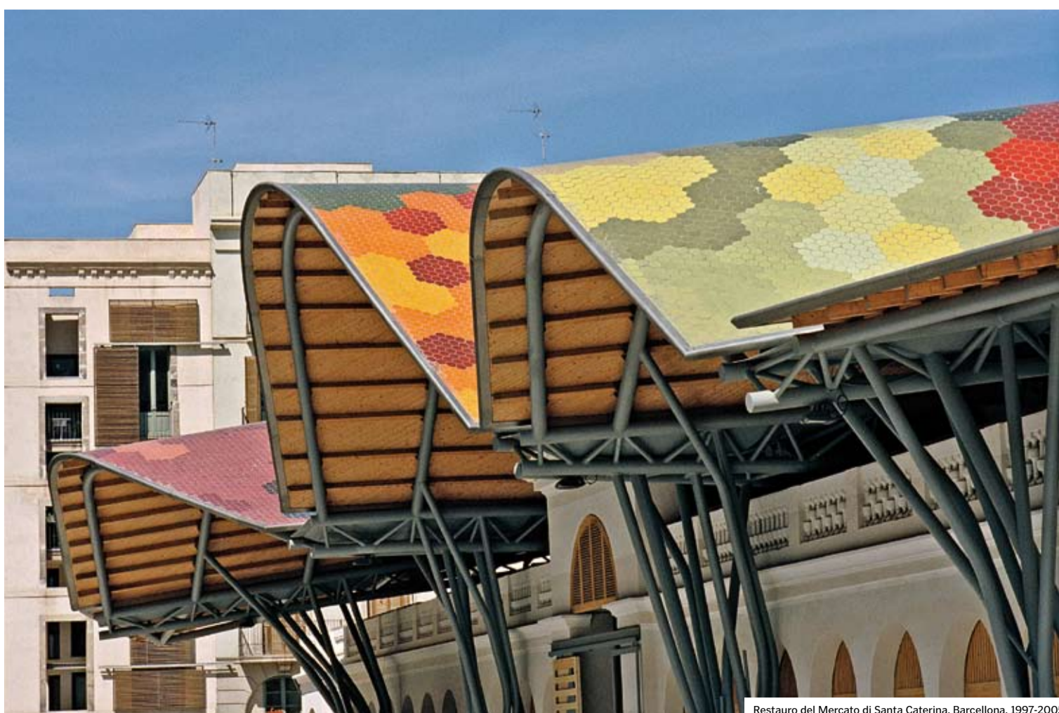
Restauro del Mercado di Santa Caterina, Barcellona, 1997-2005
