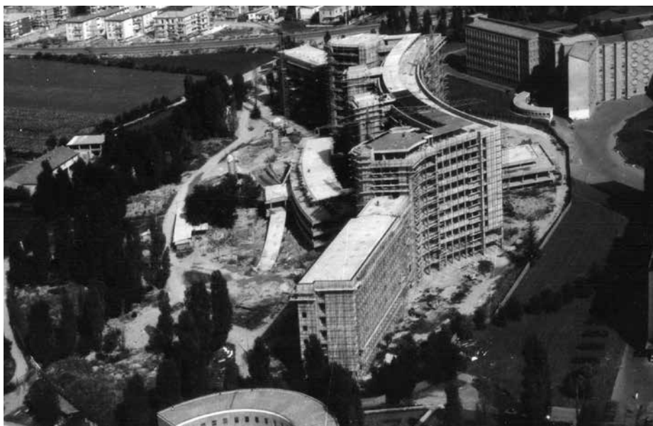
Veduta aerea del Policlinico Satellite in costruzione nel 1967.
