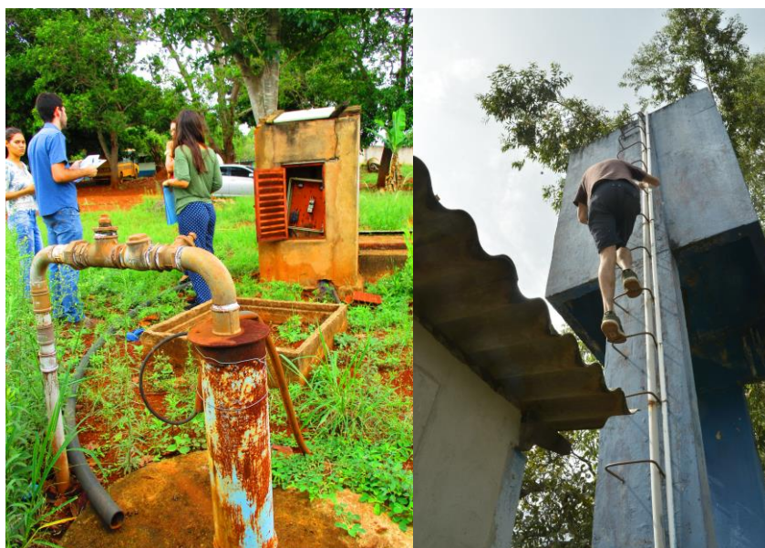
Figura 19. Pozzo e serbatoio di stoccaggio di acqua. Foto: Pugliese e Cairo
