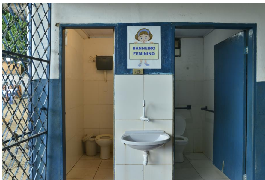
Figura 34. Bagno femminile con lavandino esterno. Foto: Leonardo Cairo
