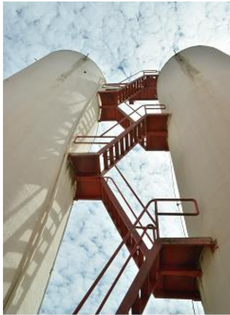
Figura 41. Serbatoio. Foto: Leonardo Cairo
