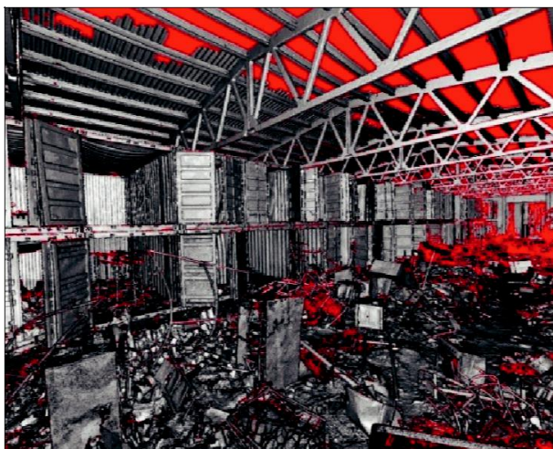
Fig. 110. – Documentazione 3D di un deposito distrutto da un incendio.
