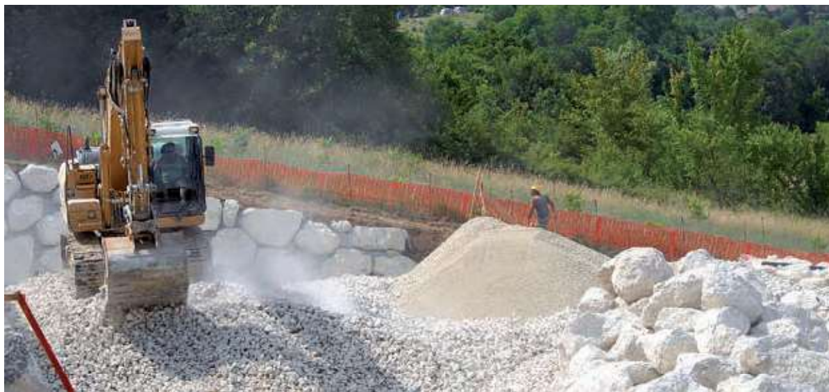
Lavoro in un cantiere di ripristino ambientale.
