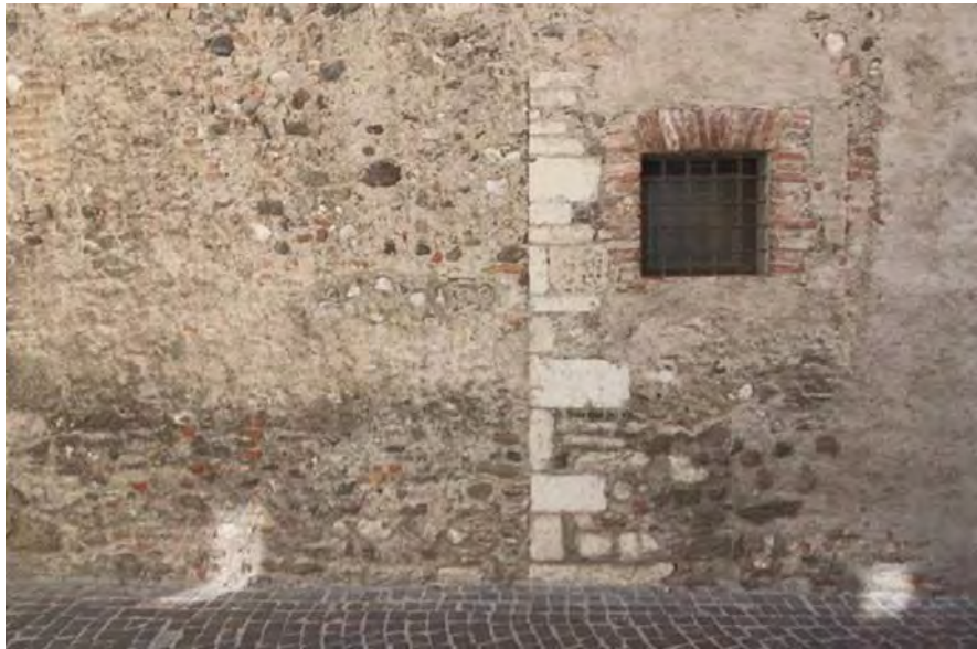
Fig. 1 – Un muro come palinsesto: tracce nella tessitura muraria della facciata nord del Museo, Gavardo – Fonte: foto di N. Ghidinelli, A. Pasini
