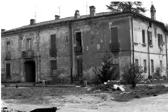
Fig. 3. Villa Grasseni prima del restauro del 1989 (AUTFlero, Fald. “Restauro ex villa Grasseni”).
