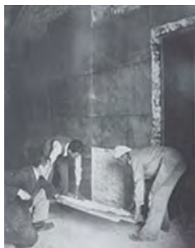
Fig. 6 - Palazzo Salvadego, Sala del Moretto. Il restauratore Ottemi della Rotta procede alle operazioni di stacco degli affreschi (ACS, MPI, DG AA.BB.AA, Archivio disegni (1925-1960), b. 3, fasc. 4 «Brescia - Palazzo Salvadego già Martinengo alla Fabbrica. Restauri danni di guerra»).
