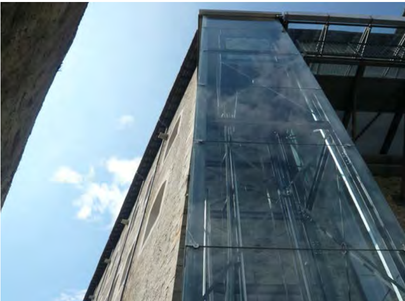
Figura 4. Forte di Bard (AO). L'ascensore verticale che porta in sommità della fortezza (foto A. Arengi).
