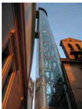
04 | Roma, monumento a Vittorio Emanuele II. La nuova torre ascensore, autonoma staticamente e matericamente nei confronti della preesistenza, è collocata nella zona retrostante del monumento, rendendo visibile solo il torrino terminale che emerge soprattutto guardando dall'area archeologica zona dei Fori, foto di Andrea Pane
