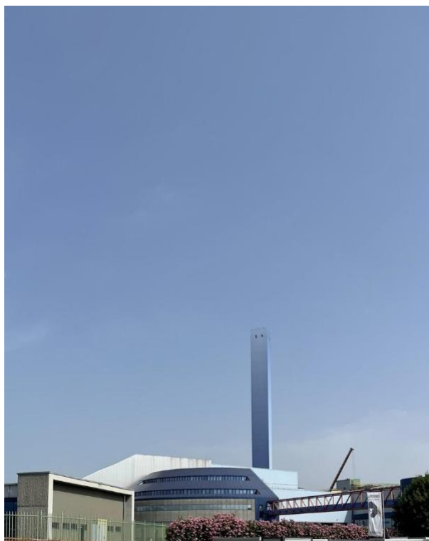
Figura 5 | Vista del termovalorizzatore di Brescia da Via Malta.
