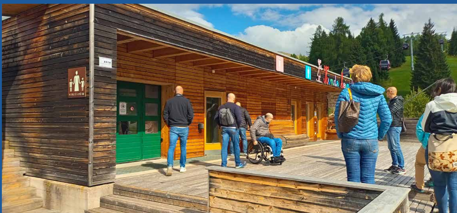
Predazzo. Area del parcheggio e rampa d'accesso alla stazione di partenza.
