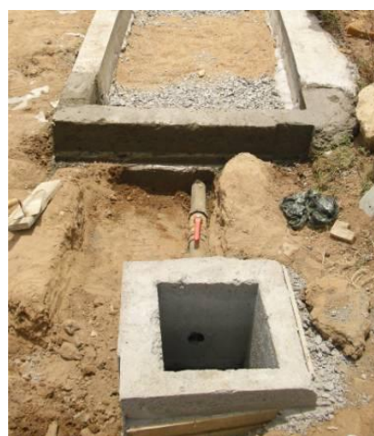
Fig. 4.30: Altra vista del pozzetto
