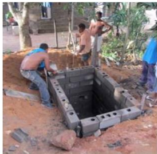
Fig. 2.9: Realizzazione di buco e pareti del pozzo settico
