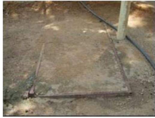
Fig 2.10 - Chiusura del pozzo, realizzazione di una copertura e di un tubo di ventilazione
