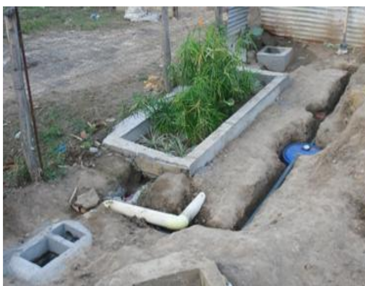
Fig. 4.4: Foto a costruzione ultimata (Aprile 2012)
