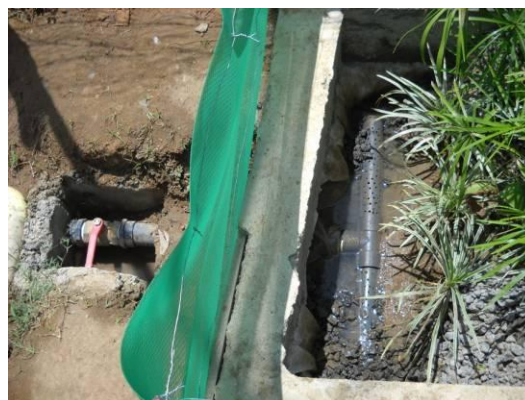
Fig. 4.17 Tubo forato in entrata al fitodepuratore
