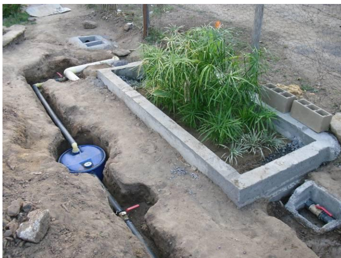
Fig. 4.22 Filtro anaerobico in parallelo al fitodepuratore
