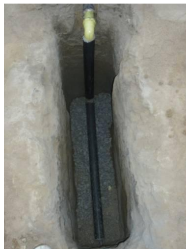
Fig. 4.33: Sistema di infiltrazione
