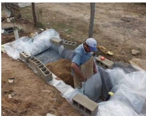
Fig. 4.15 Inserimento del materiale filtrante
