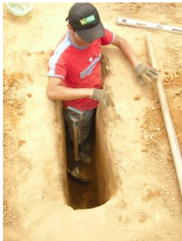
Fig.4.32: Operazioni di scavo
