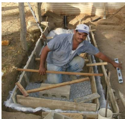
Fig. 4.16 Impermeabilizzazione fissata
