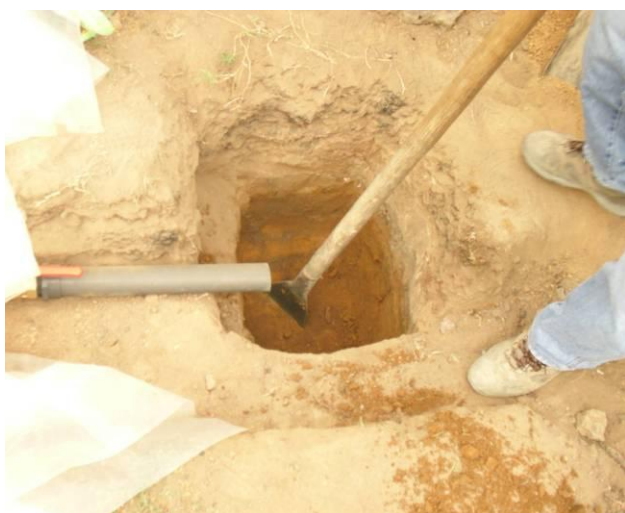
Fig. 4.27: Operazioni di scavo
