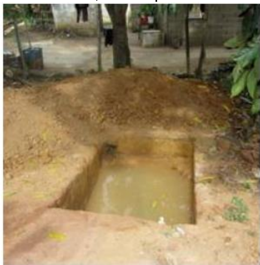
Fig. 2.9: Realizzazione di buco e pareti del pozzo settico
