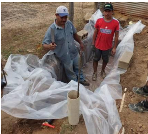
Fig. 4.14 Impermeabilizzazione
