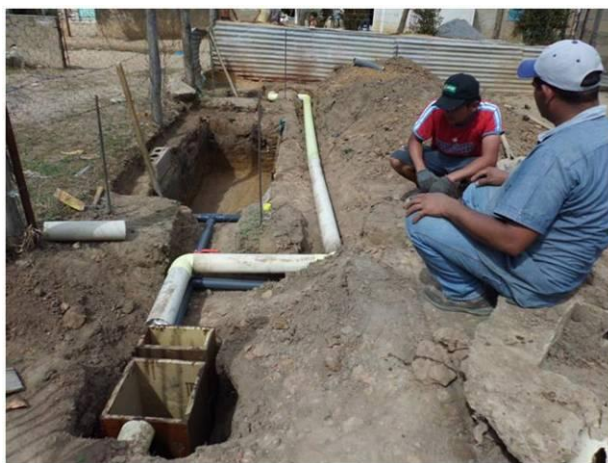
Fig. 4.13 Realizzazione del by-pass
