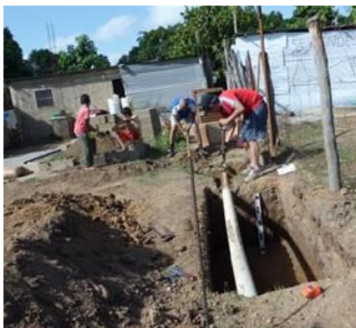
Fig. 4.12 Scavo e tubazione originaria
