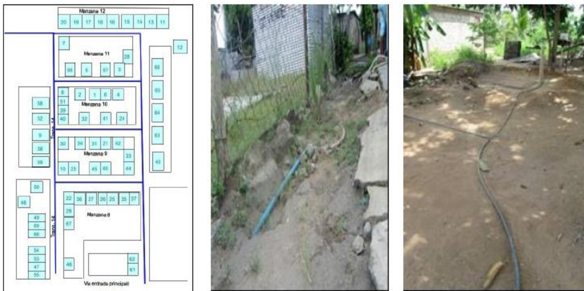
Fig 2.6: Mappa con indicazione del percorso del sistema di aprovisionamento di acqua potabile (immagine a sinistra) e situazione presente nel quartiere (immagine centrale e di destra) (Missione in loco CeTAmb)
