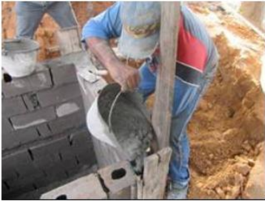
Fig 2.10 - Chiusura del pozzo, realizzazione di una copertura e di un tubo di ventilazione
