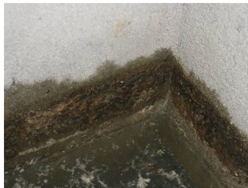
Fig. 4.6: Grassi e oli sulle pareti della trappola
