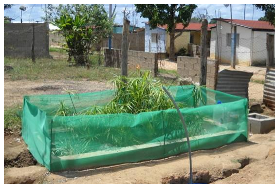
Fig. 4.19: Realizzazione di una protezione al filtro
