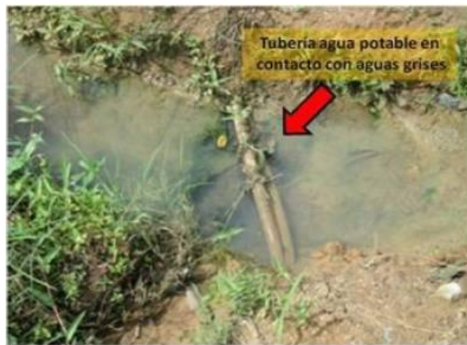
Fig. 2.11: Tubo di condotta di acqua potabile a contatto con acqua grigia
