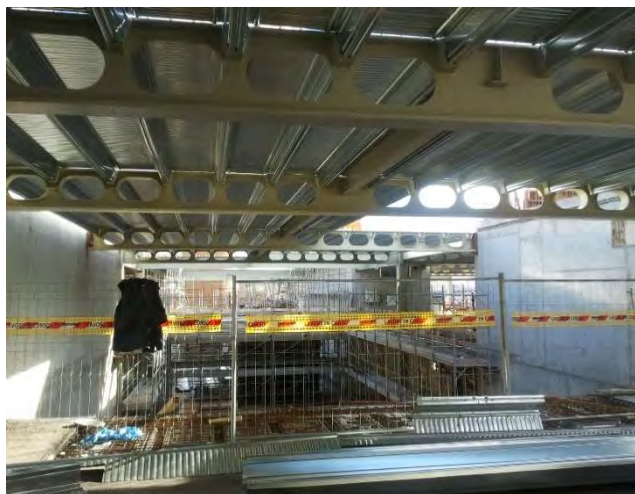
Figura 40 - Vista d'insieme dell'edificio (in alto), vista delle forature in cantiere delle travi principali e montaggio delle facciate vetrate (in basso). Foto: Luc Boegly; Redesco Progetti srl (vista interna)
