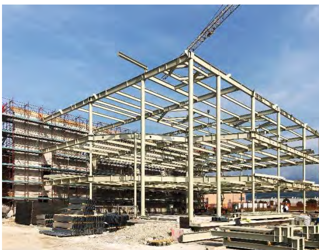
Figura 44 - Vista d'insieme del Battistella Headquarter (in alto), fasi di cantiere della struttura in acciaio dell'edificio e vista degli interni (in basso). Foto: Marco Zanta (finito); PICHLER projects srl (cantiere)
