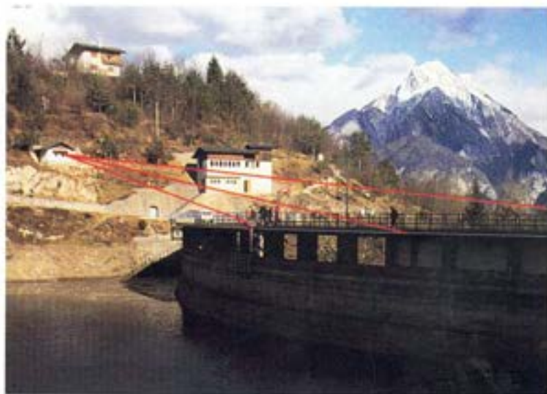
Fig. 2 - L'installazione di ISAC 5000 presso la diga di Ambiana.
