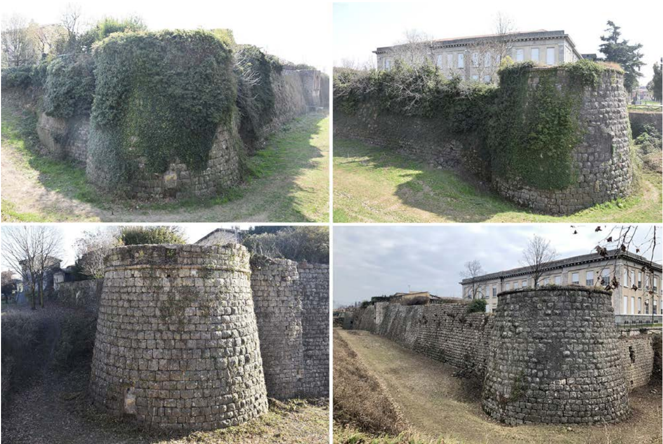
Fig. 2. Particolare delle cortine murarie prima (febbraio 2021) e dopo l'avvio dei cicli di rimozione della vegetazione infestante (febbraio 2022). A sinistra: viste del torrione nord-ovest (canton Pusterla). A destra: viste del torrione sud-ovest (canton Cattaneo) e di porzione del fronte occidentale (foto S. Barbò, C. Coccoli 2021-2022).
