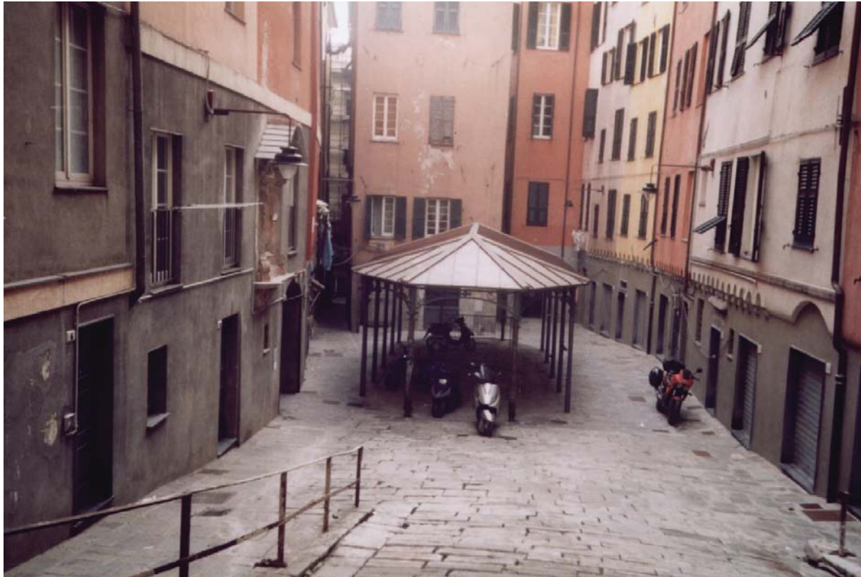
Fig. 6 Italia, Genova, Piazza Santa Brigida. I Trogoli, dopo il restauro del 2006 - © Collezione dell'autore.
