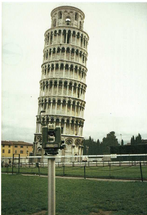
Fig. 13 – Il vertice di stazione 11 con teodolite Wild T2000 accoppiato al distanziometro Wild DI2000 posizionato sul pilastro metallico
