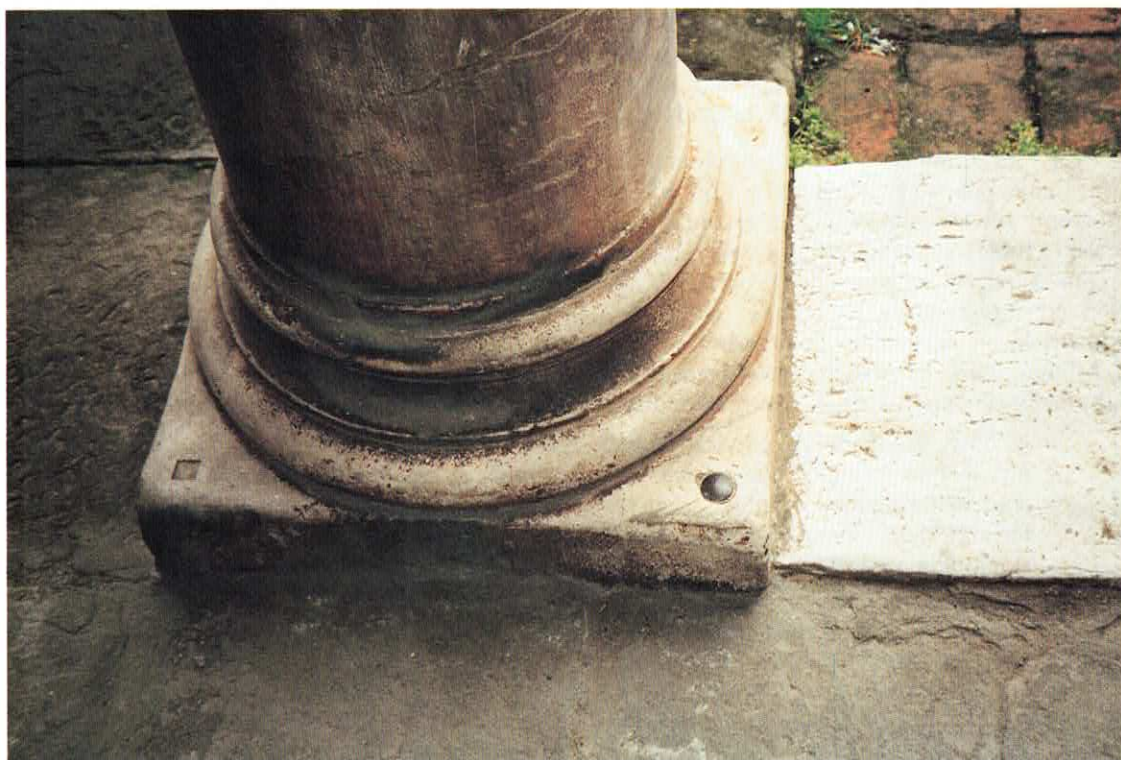
Fig. 3 - Il capisaldo di livellazione \psi' (installato nel 1928 dal Prof. Cassinis) posto sulla base della colonna del cortile dell'Arcivescovado, immediatamente a destra entrando
