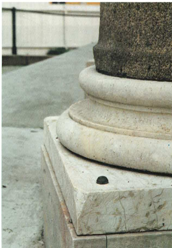
Fig. 5 – Immagine dei capisaldi in bronzo posizionati nel 1965 sui basamenti delle 15 colonne poste alla base esterna della Torre
