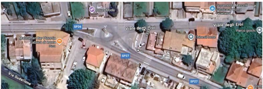
Figura 8.40 Classificazione degli archi e delle intersezioni critiche alla transitabilità dei mezzi pesanti – 4 di 4.
