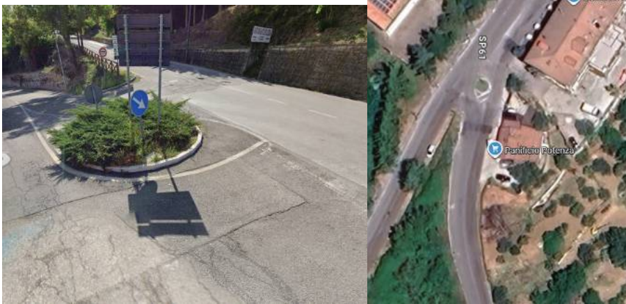
Figura 8.140 Classificazione degli archi e delle intersezioni critiche alla transitabilità dei mezzi pesanti – 2 di 3.
