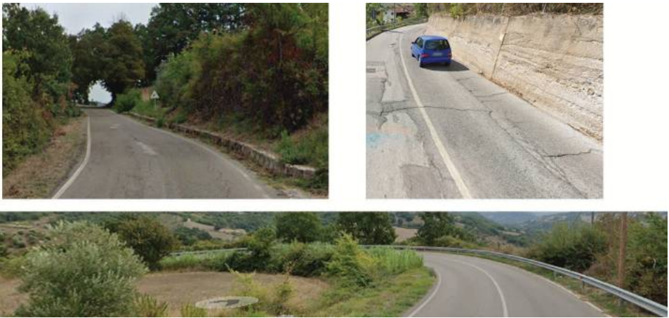
Figura 8.138 Viste prospettive delle strade appartenenti alle alternative di percorso individuate, a seguito di sopralluoghi conoscitivi.
