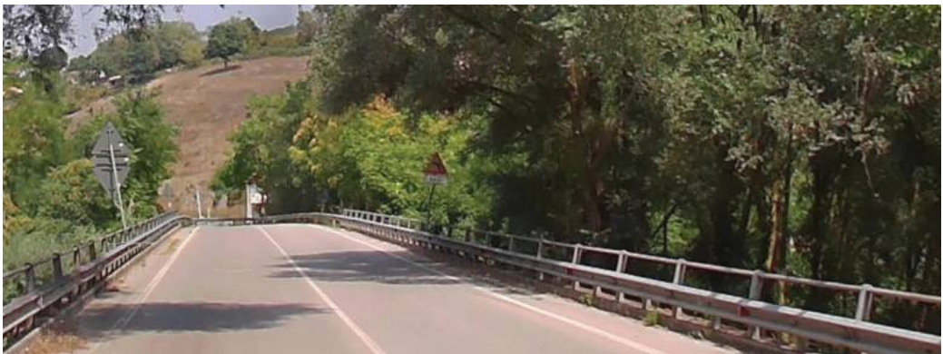
Figura 8.128 Rappresentazione prospettica del sito considerato nel Caso di Studio 7 (fonte: Google Street View).
