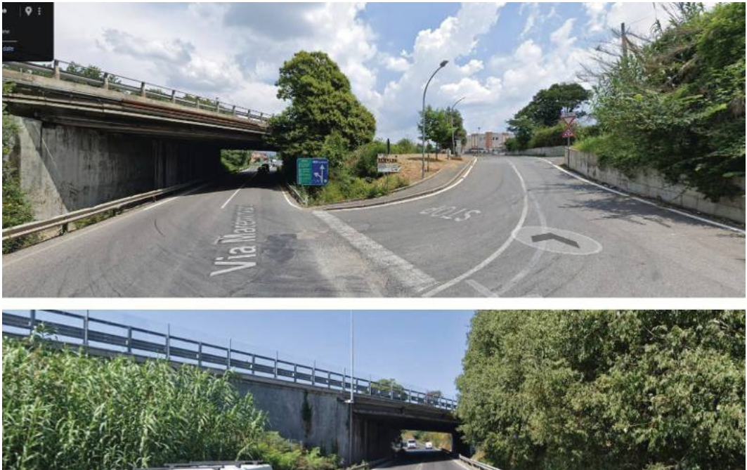
Figura 8.52 Rappresentazioni prospettiche del sito considerato nel Caso di Studio 4 (fonte: Google Street View).
