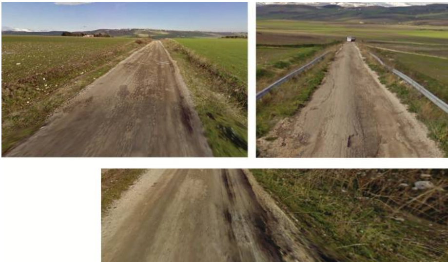
Figura 8.166 Classificazione degli archi e delle intersezioni critiche alla transitabilità dei mezzi pesanti – 5 di 8.
