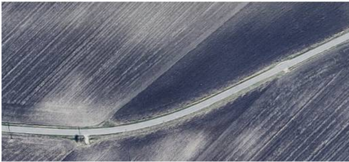
Figura 8.167 Classificazione degli archi e delle intersezioni critiche alla transitabilità dei mezzi pesanti – 6 di 8.
