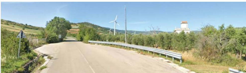
Figura 8.145 Rappresentazione prospettica del sito considerato nel Caso di Studio 8 (fonte: Google Street View).
