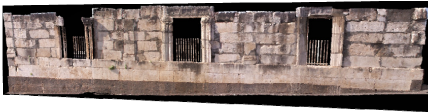
Figura 10. Prospetto della sinagoga a conclusione della fase di mappatura delle prese acquisite con camera fotografica indipendente dallo strumento.
