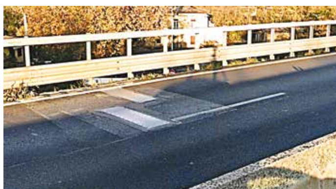
4. La rappresentazione fotografica del sistema WIM installato dalla Provincia di Brescia per monitoraggio del carico veicolare transitante sul ponte
