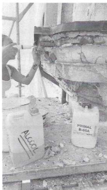
Figura 8 Intervento di consolidamento con iniezioni
