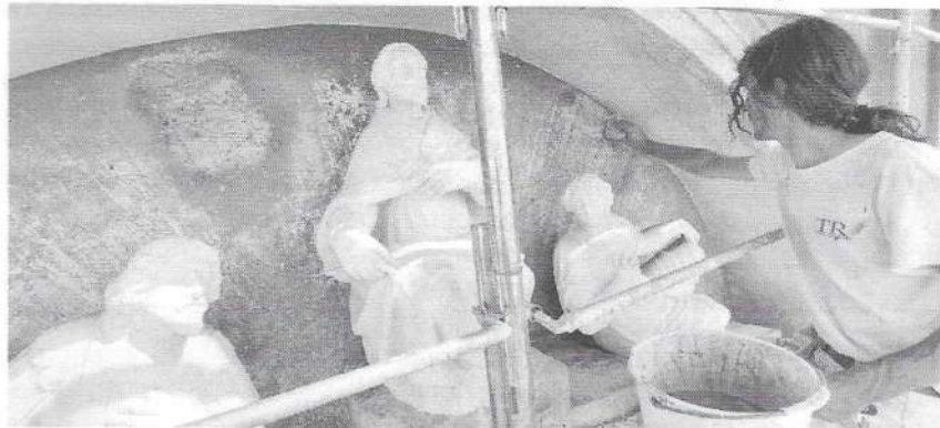
Figura 13 rimozione del colore azzurro della nicchia: durante l'operazione sono emersi i raggi dorati
