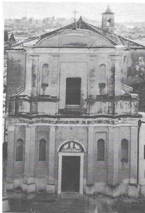
Figura 1 facciata prima dell'intervento di restauro
