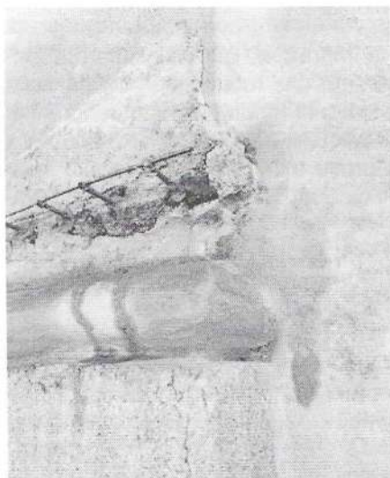
Figura 9 Intervento di consolidamento con perni metallici
