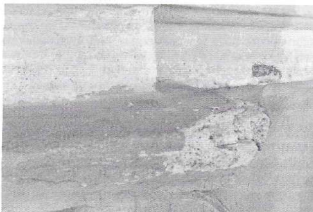
Figura 6 la cornice è formata da tavelle in cotto coperte da intonaco di calce e durante gli ultimi restauri da una rasatura cementizia
