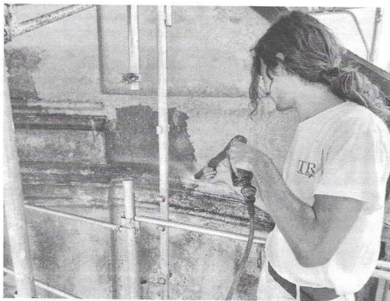
Figura 4 lavaggio con rimozione dei residui di biocida e di deposito
