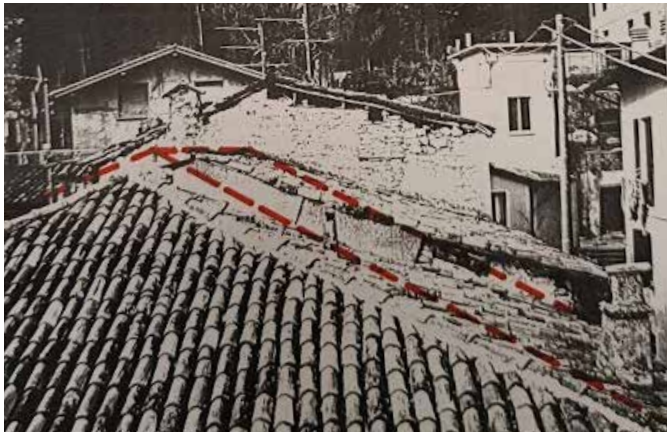
Fig 13 - esempi di edificio con richiesta di modifica di classificazione all'interno dello strumento urbanistico.
