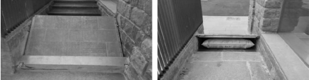
Fig. 14, 15. Esempio di paratoie anti-allagamento a protezione degli ingressi (HAB, 2020).
