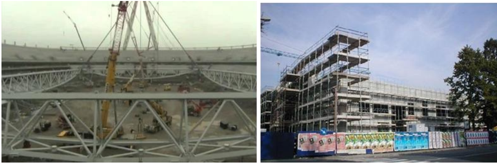
Figura 3.10 - Costruzione dello Juventus Stadium e del Palazzetto del ghiaccio di Torino [35]
