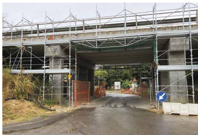
3. Il ponte pilota situato sulla strada BSSPEXSS45BIS nel comune di Bassano Bresciano (BS), individuato in accordo con la Provincia di Brescia (Ente gestore) per una prima implementazione del progetto
